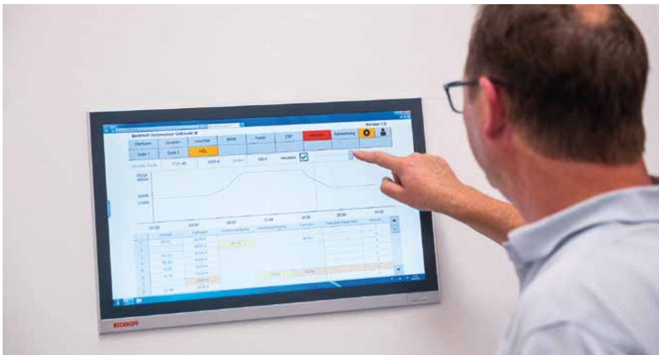
In der Beckhoff-Klemmenfertigung ist das Thema HCL in eine IoT-Umgebung eingebunden und integraler Bestandteil der Gebäudeautomationsplattform Twincat Building Automation, die den Lichtverlauf steuert und überwacht
