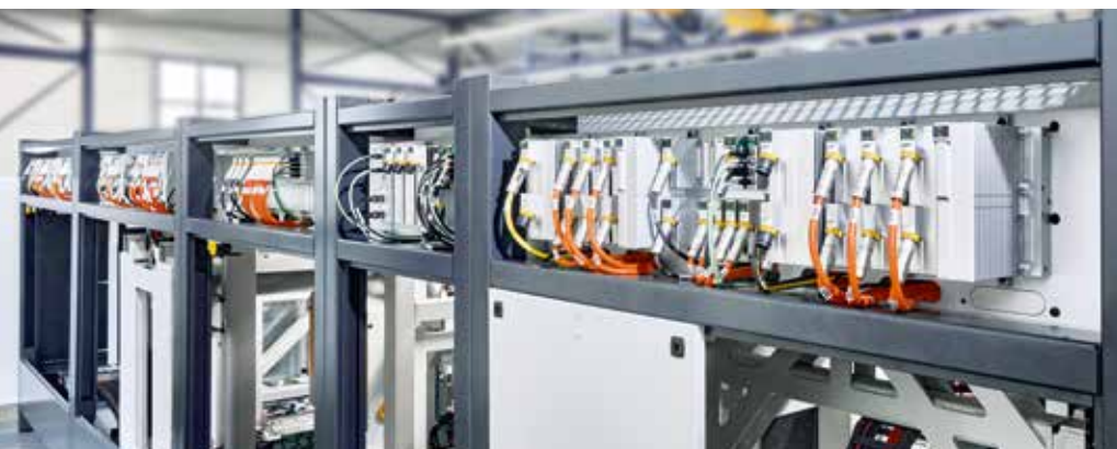
对于自动化工程师来说, 系统的背面尤其有趣, 因为每个设备模块都有自己的 MX-System 底板, 各个功能模块可以直接插接并用螺钉固定在上面
