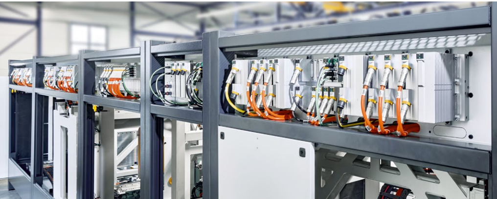
자동화 엔지니어들에게 특히 흥미로운 부분은 시스템의 후면입니다. 각 기계 모듈마다 자체 MX-System 베이스플레이트가 있어, 여기에 다양한 기능 모듈을 장착하고 고정할 수 있기 때문입니다.
