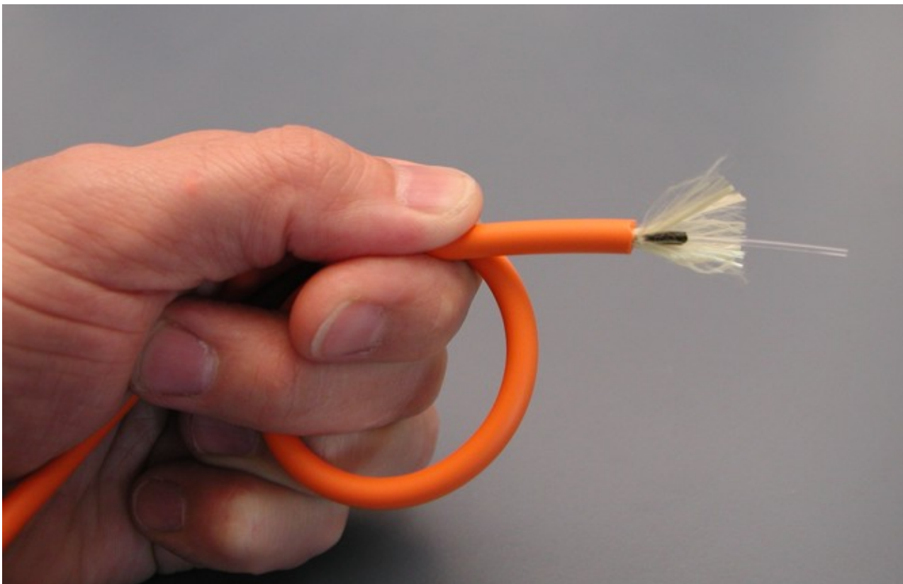
Fixierung der IP-Link-Leitung zur Abisolierung
