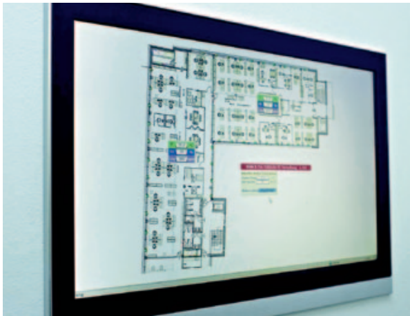
Über ein 15,6-Zoll-Controlpanel auf jeder Büroetage können Sollwerte verändert sowie die Statusinformationen aus der Anlagen- und Raumautomation abgerufen werden.
