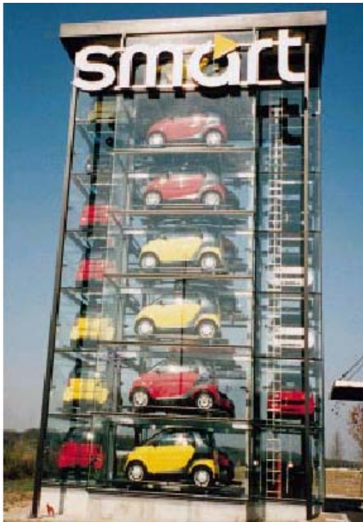
Автомобили Smart располагаются за стеклянными стенами башни, занимающей в основании площадь всего лишь 67,24 м 2 . Привлекательная конструкция башенной парковки Smart Tower позволяет ей выполнять сразу две функции: интеллектуальной системы хранения, а также эффективной демонстрационной площадки для продажи автомобилей.
