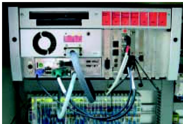
Управление от Beckhoff: встраиваемый в шкаф PC C6240 и интеллектуальные модули ввода-вывода с контроллером узла промышленной шины SERCOS.
