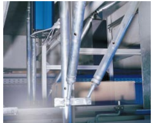
Scanner, die über den Lightbus mit dem Rechner kommunizieren, generieren Signale für den Materialfluß.
